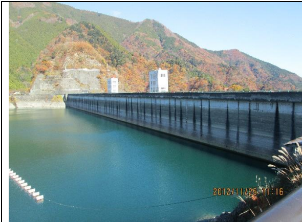
[巡検地 No,2] 小河内ダム …東京水道局が管理する多摩川のダムで重力式コンクリート式ダム。標高は 530mにある。放水路は右側の写真のように青梅街道に沿ってある。
