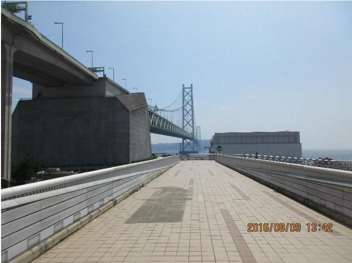
兵庫県明石市と淡路島を結ぶつり橋。橋の上は神戸淡路鳴門自動車道が通っている。3,911 mの長さで東京タワーとほぼ同じ高さの主塔を持つ明石海峡大橋は塔と塔の間の長さが世界一である。
