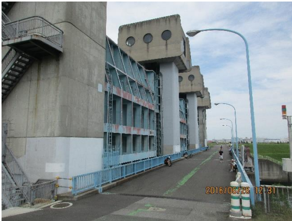
ダムの管理室への階段です。電気がついてないので誰もいないでしょう。
